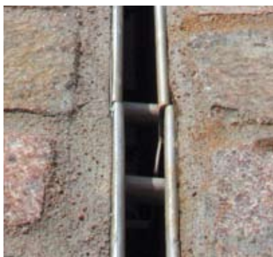
Samling uden brug af Brickslot klips.
